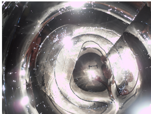
Figura 3.30: Pareti interne della WaterTank rivestite con il DF2000MA.
